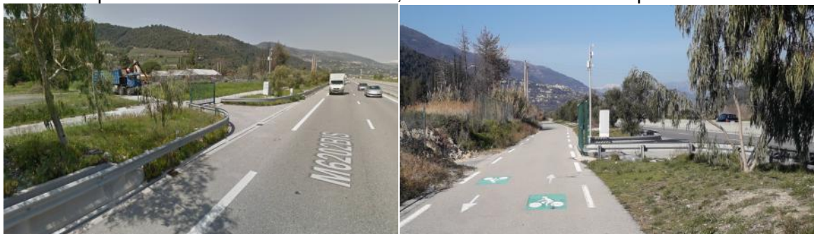
Figure 70 : Vue de l'entrée en phase travaux
